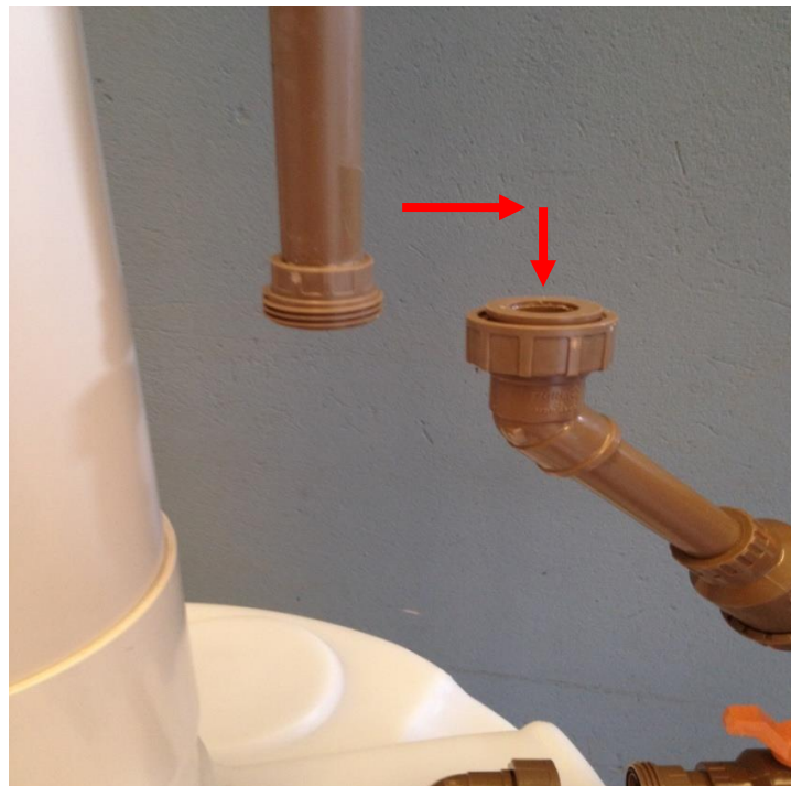
b) Conexão das tubulações entre a torre e o reservatório
