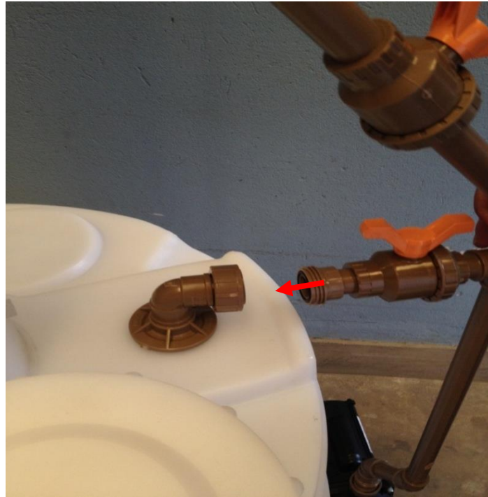
b) Conexão das tubulações entre a torre e o reservatório
